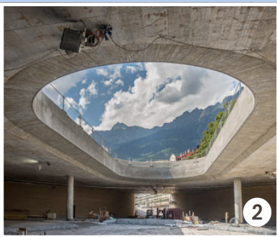
2 Die Umfahrung Meran verknüpft unterirdisch Straße und Bahn. Assessorat Bauen
